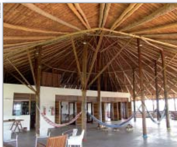
Terceiro andar da nova sede, com a cobertura de piaçaba, construída pelos Coripaco
