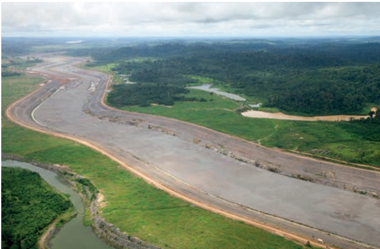
Construção do canal de 20km de comprimento que desviará o Rio Xingu (PA)
