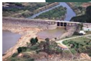
> barragem do reservatório Jaguari/Sistema Cantareira praticamente seca. (25/11/2003. Foto: IATÁ CANABRAVA)
